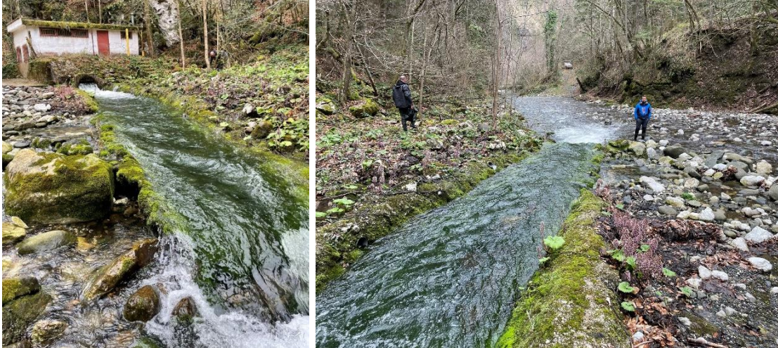
Slika 40. Kaptaza izvorišta "Izron" i prelivni betonski kanal
