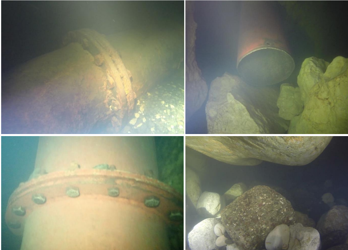
Slika 57. Stanje kaptažne natege i dna vrelnog kanala (DDISKF Zagreb, 2018)
