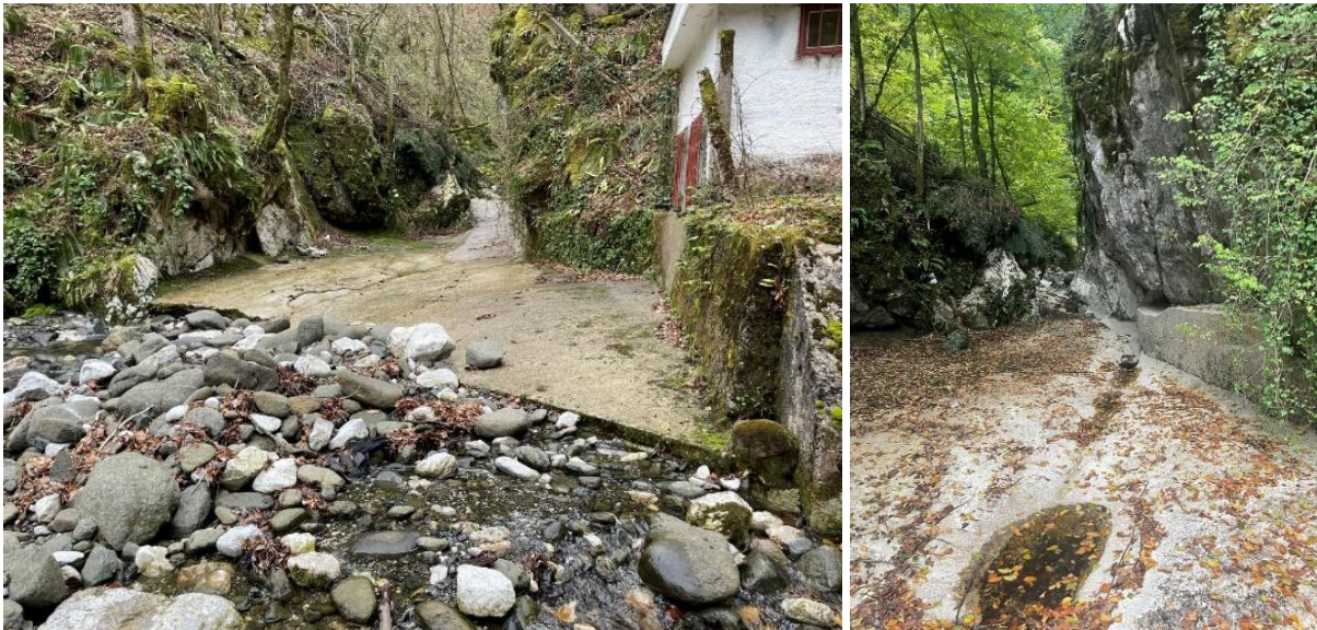
Slika 41. Dijelom betonirano korito rijeke Suhe uzvodno od izvorišta "Izron"
