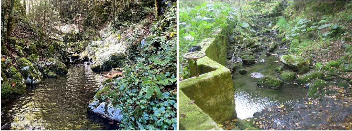
Slika 52. Korito Tajašnice uzvodno (lijevo) i nizvodno (desno) od vodozahvata
