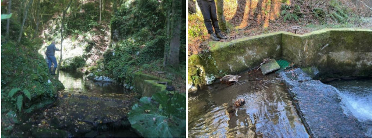
Slika 51. Krilni zid, prag i slapište vodozahvata "Tajašnica" (lijevo), rešetka, regulacioni zatvarač, prag i slapište (desno)
