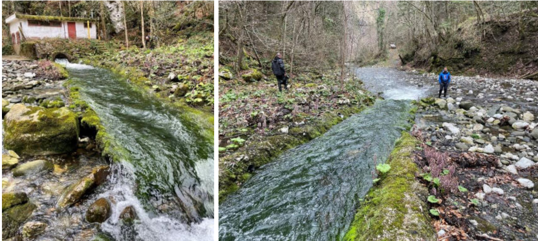
Slika 40. Kaptaza izvorišta "Izron" i prelivni betonski kanal
