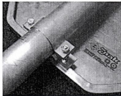
*Slika: Način vezivanja saobraćajnog znaka za stub*
